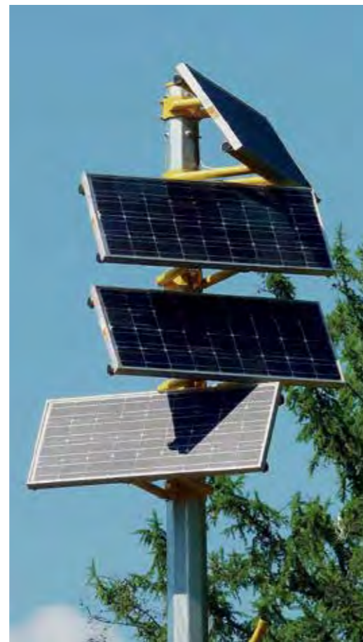
Пример автономной опоры с фотоэлектрическим преобразователем в «Олимпийском парке» Autonomous lamp with photovoltaic cell in the Olympic Park
