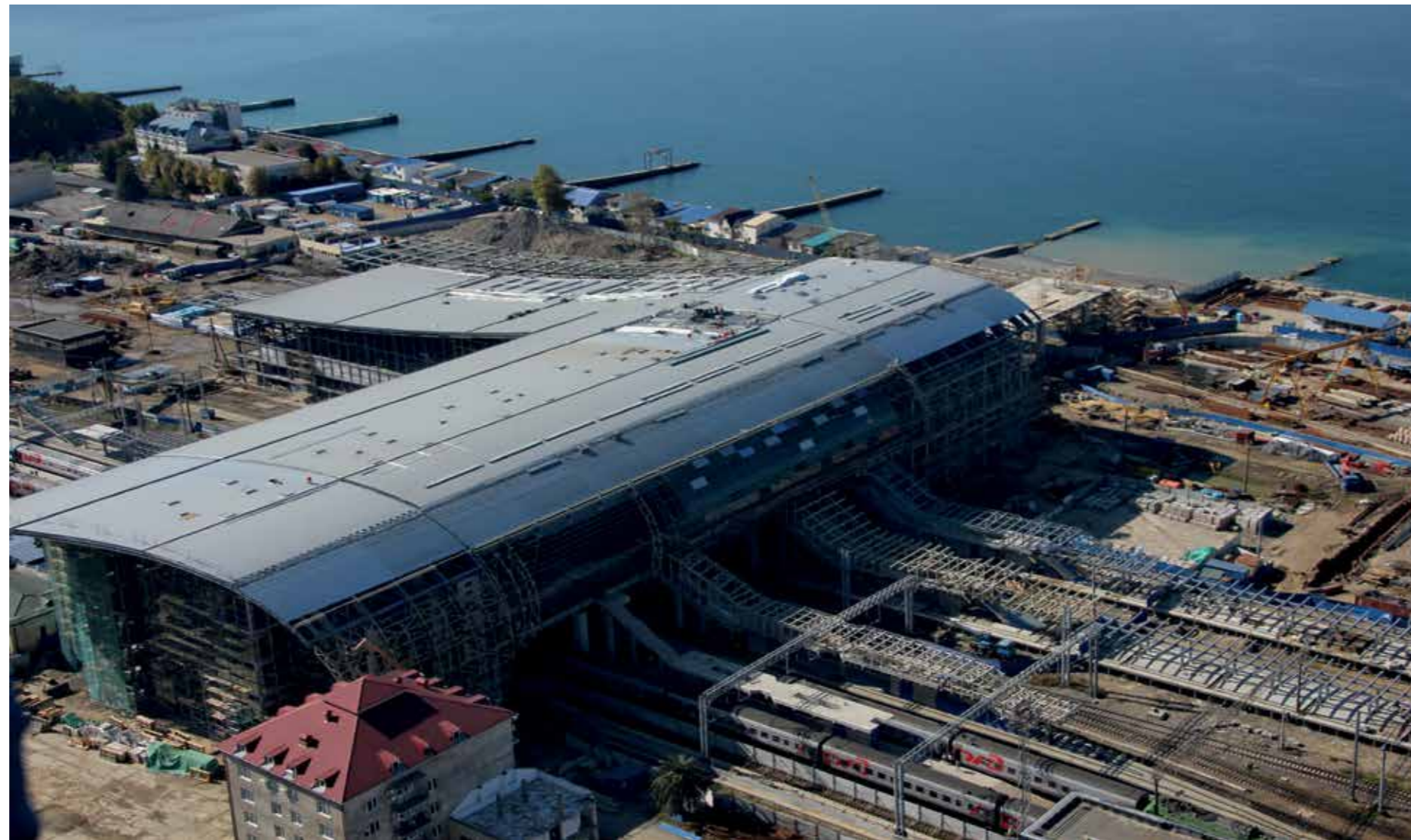
Железнодорожный вокзал «Адлер». Август 2012г. Adler railway station. August 2012
