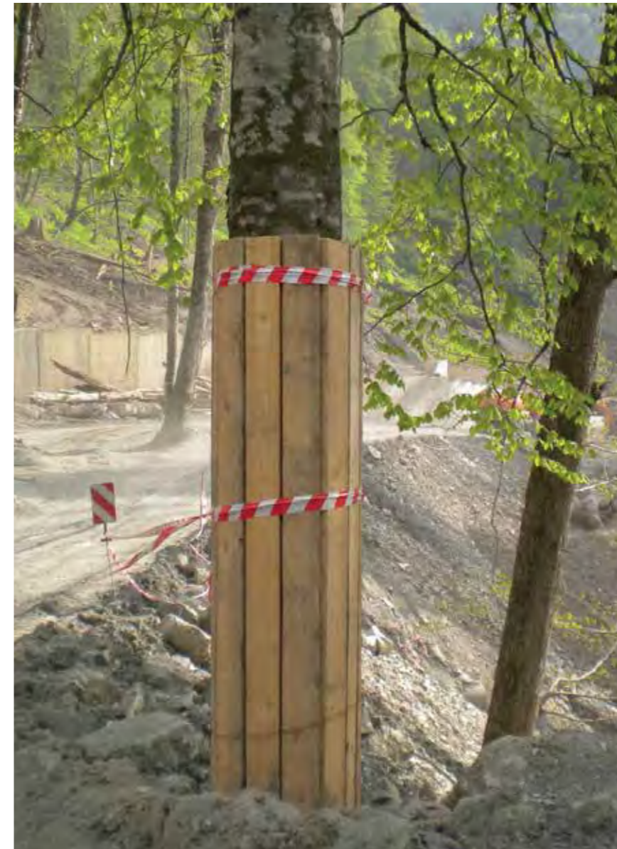
Пример защиты деревьев при строительстве автомобильной дороги от курорта «Альпика-Сервис» до курорта «Роза Хутор» Example of protection of trees during the construction of the highway from the Alpika Service resort to the Rosa Khutor resort
