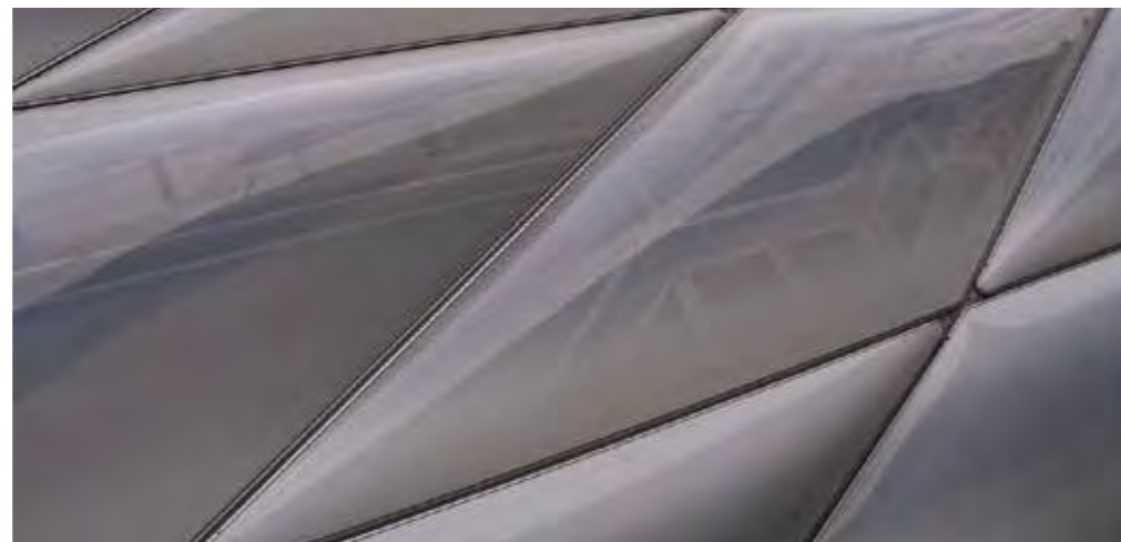
Материал ETFE в технологическом решении Texlon® ETFE material
