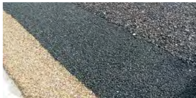
Внешний вид участка берегоукрепления по предложенной технологии Эластокоаст. Сентябрь 2012 года External view of the embankment reinforcement using the proposed Elastocoast® technology. Final stage of the pilot project in the bank reinforcement region of the Imeretinskaya Valley. September 2012
