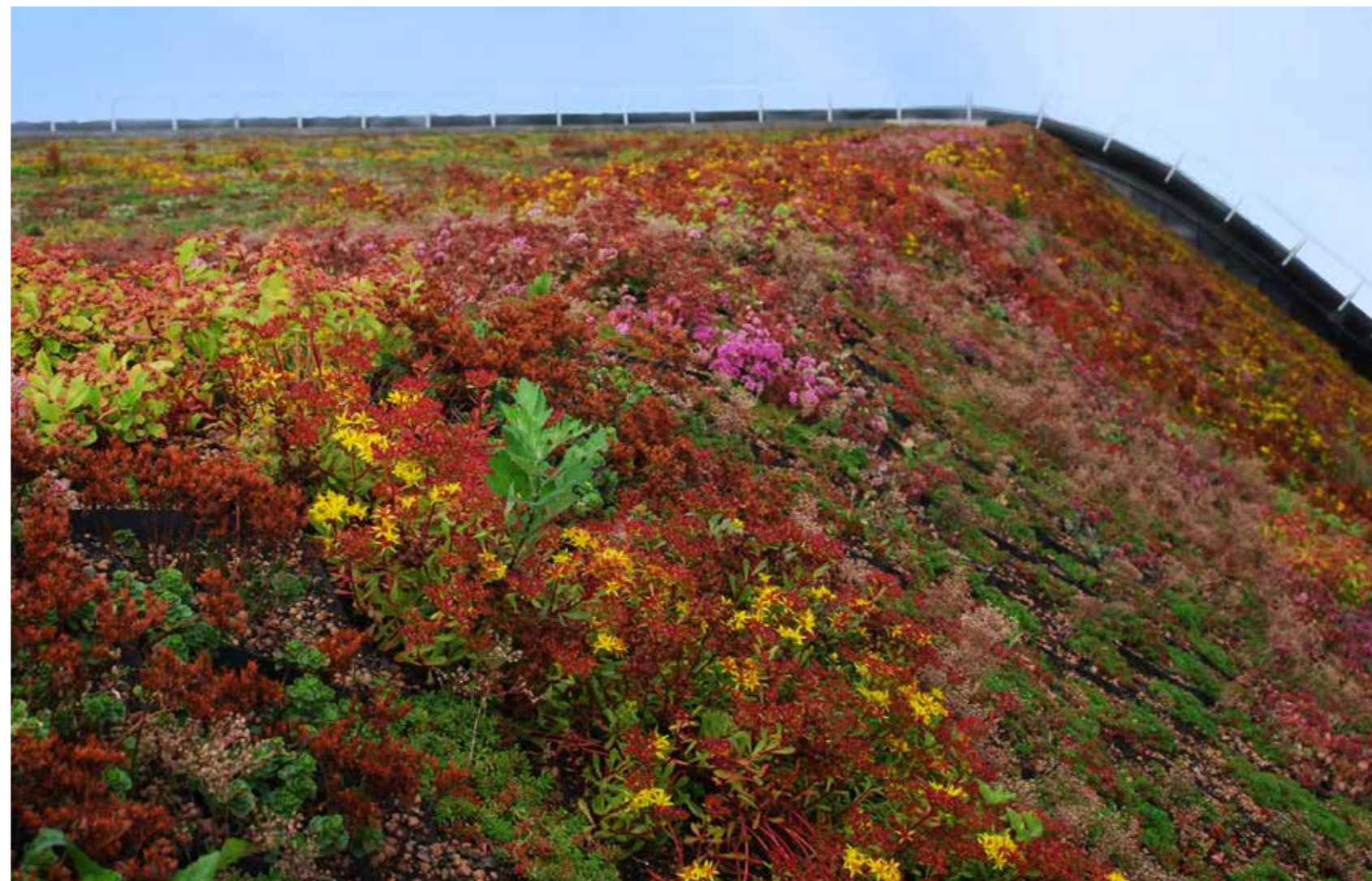
Пример «Зеленой крыши» на объекте строительства Example of a green roof
