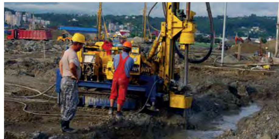
Инъектирование Injection
