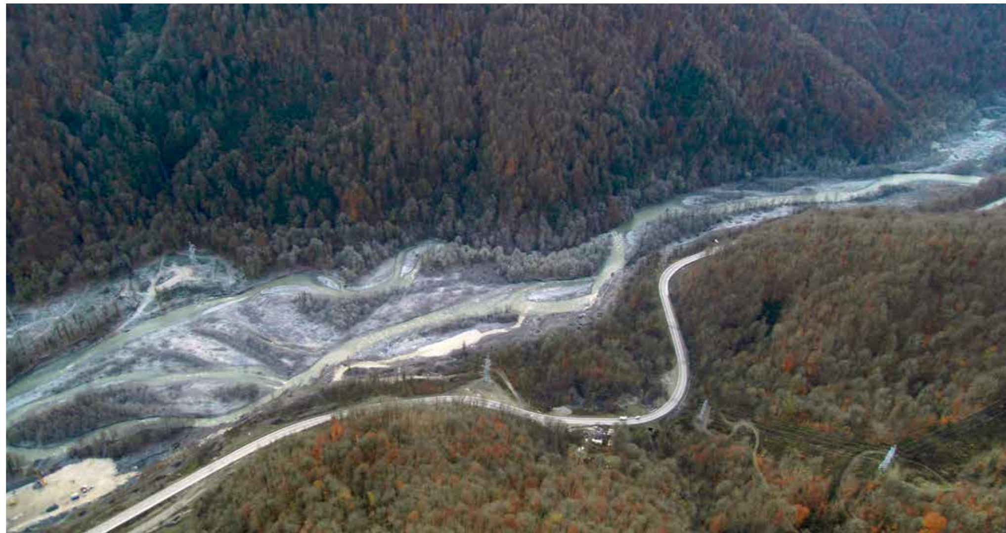
Аэрофотосъемка участка автомобильной дороги от курорта «Альпика–Сервис» до курорта «Роза Хутор». Сентябрь 2011 г. Aerial photograph of the site of the highway from the Alpika Service resort to the Rosa Khutor resort. September 2011
