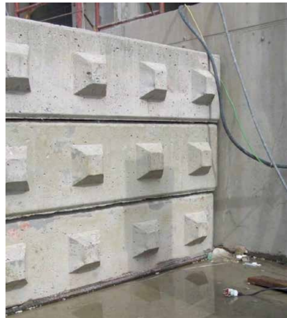
Произведенные из отходов бетонные блоки Concrete blocks produced from construction waste
