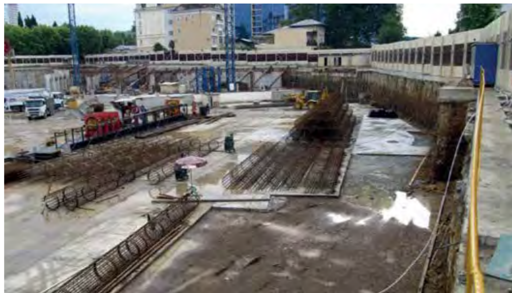
Изготовление свайных арматурных каркасов на стройплощадке РМОУ Preparation of reinforced pile frames at the RIOU construction site
