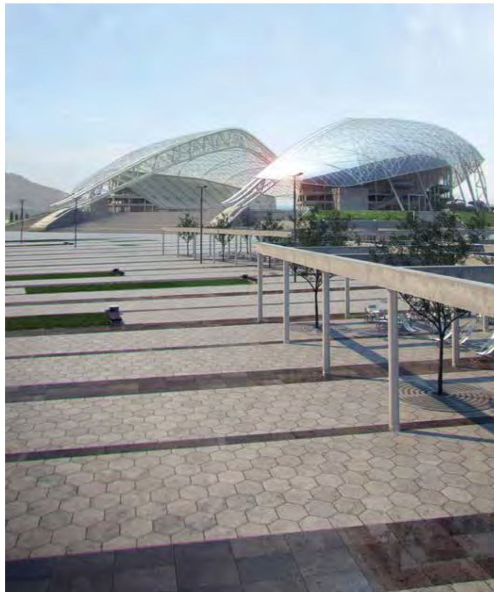
Визуализация стадиона «Фишт» с прозрачной крышей из материала ETFE, собранной по технологии Texlon® Photograph of the awning project at the "Fisht" Olympic Stadium using the Texlon® system
