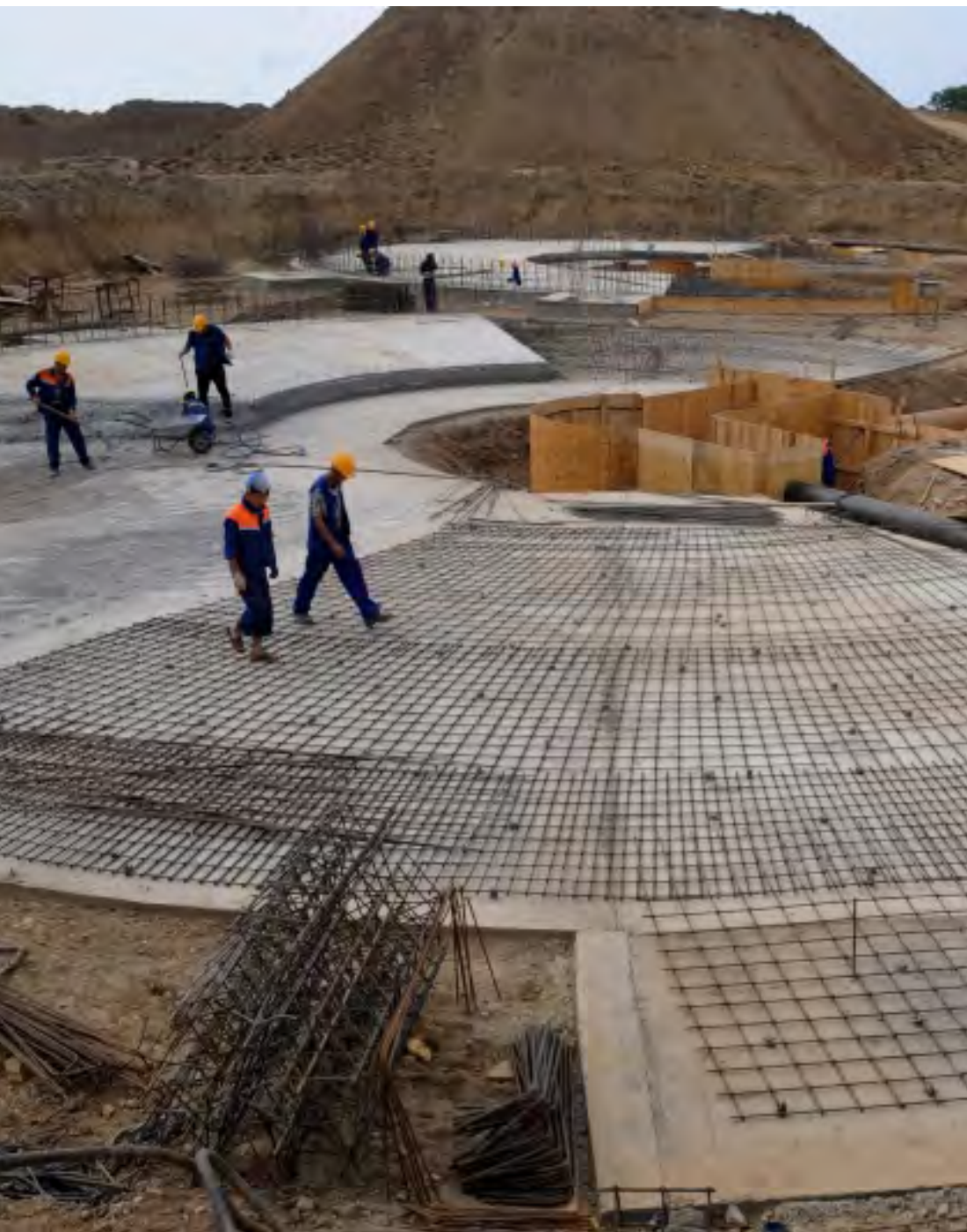
Строительство аэротенка очистных сооружений канализации в Адлерском районе Construction of the aerotank of the waste water treatment Adler
