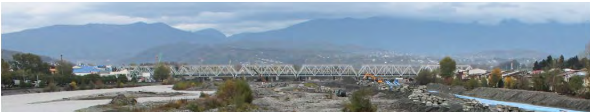
Строительство железнодорожного моста через реку Мзымту Construction of a railway bridge over the Mzymta river
