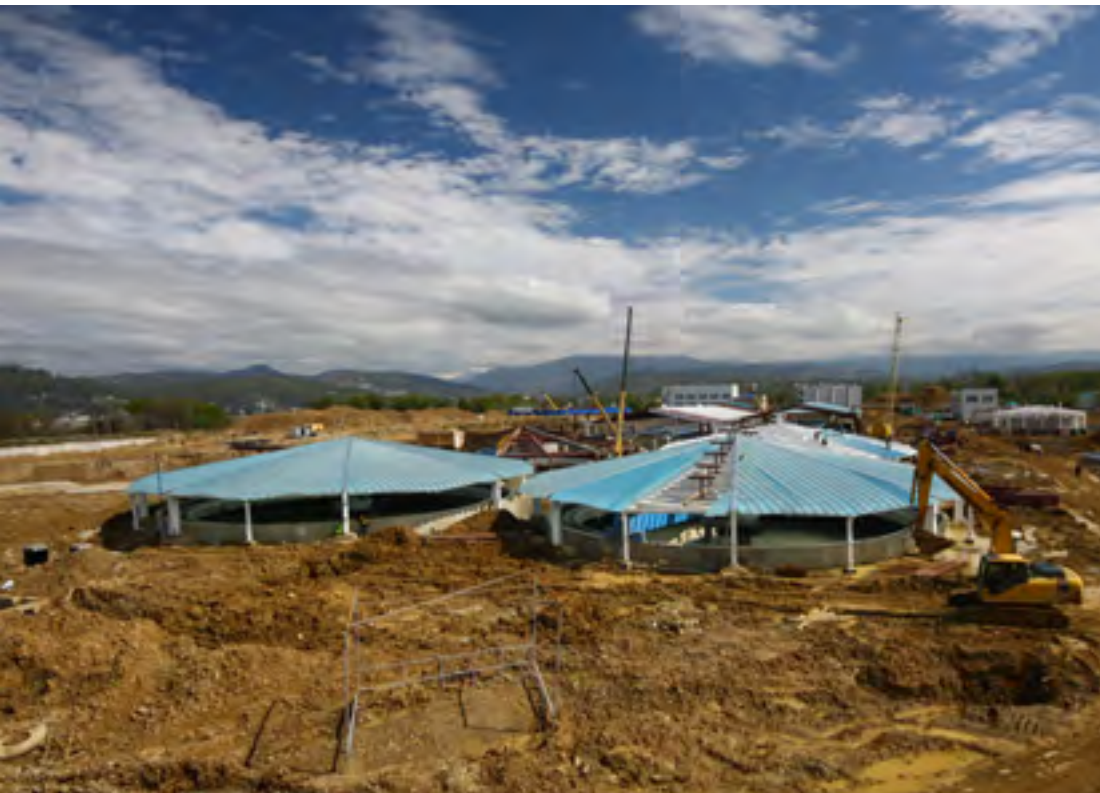
Строительство аэротенка очистных сооружений канализации в Адлерском районе Construction of the aerotank of the waste water treatment Adler
