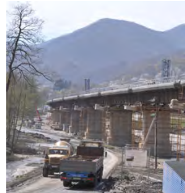
Строительство совмещенной дороги Адлер - Альпика-Сервис
