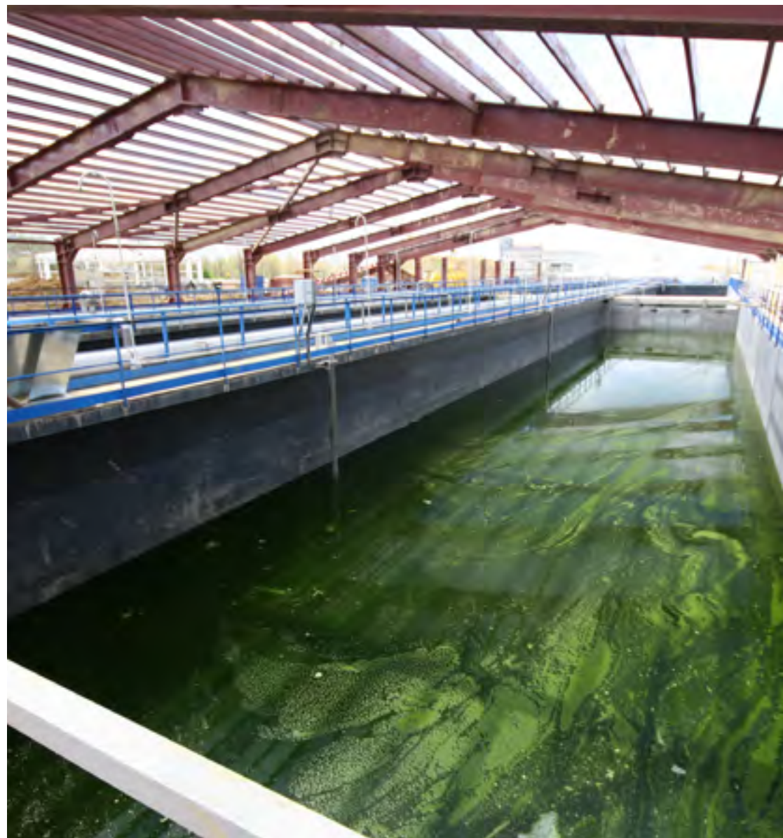
Очистные сооружения канализации в Адлерском районе The waste water treatment Adler
