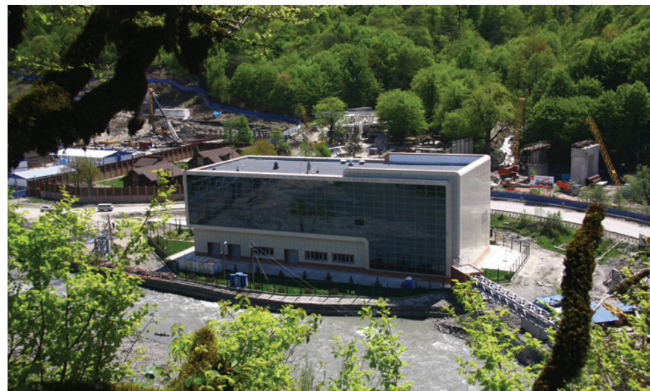
Подстанция «Лаура» в Горном Кластере The Laura electrical power substation in Mountain cluster
