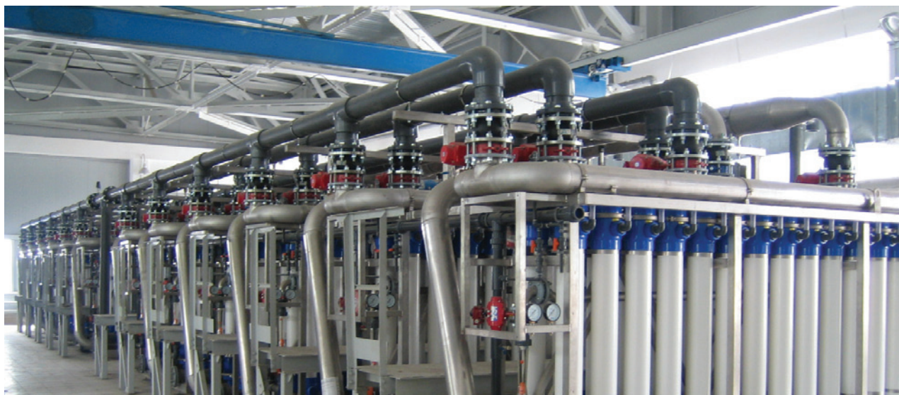
Блок микрофльтрации Microfiltration unit
