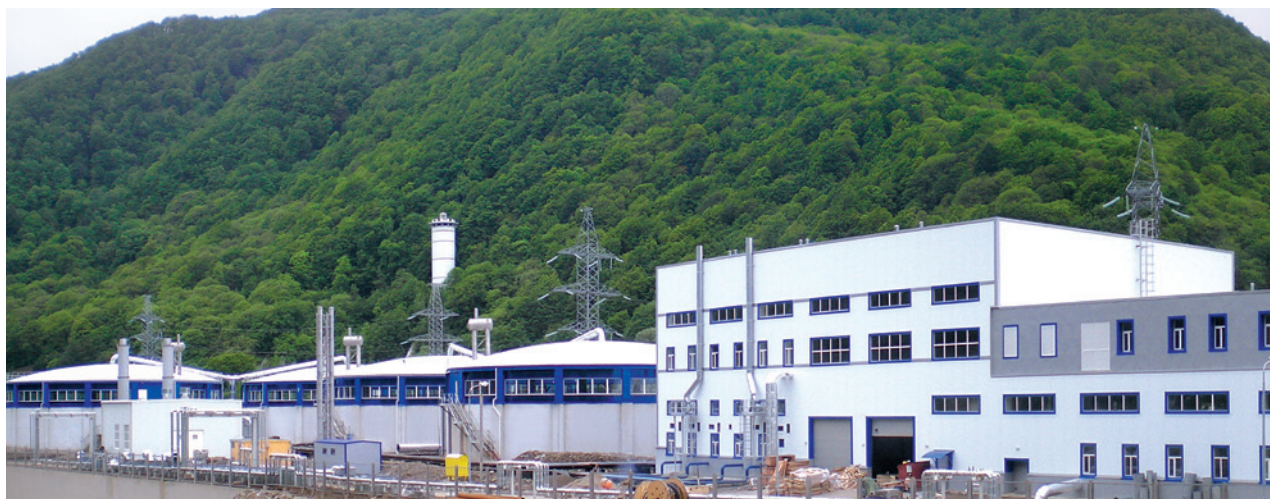
Общий вид очистных сооружений General view of the Waste Water Treatment
